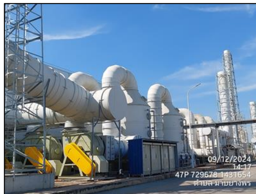
ภาพที่ 3 ระบบบำบัดมลพิษทางอากาศ
